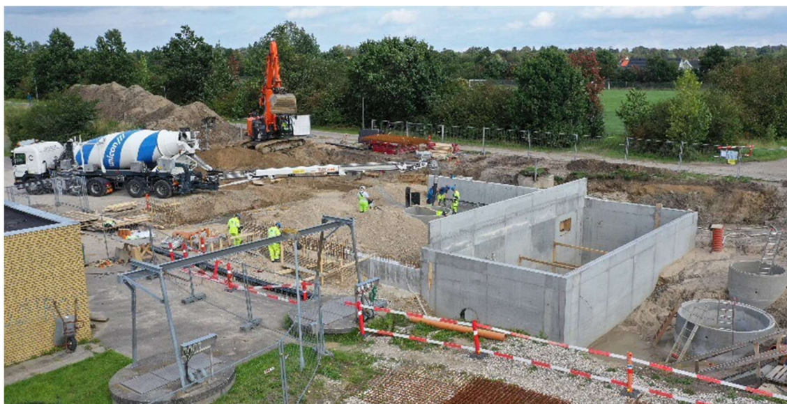
Eksempel på udgravning og støbearbejde.
