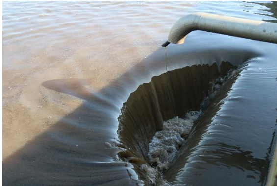
Afløb processtank © Mariagerfjord Vand A/S.
