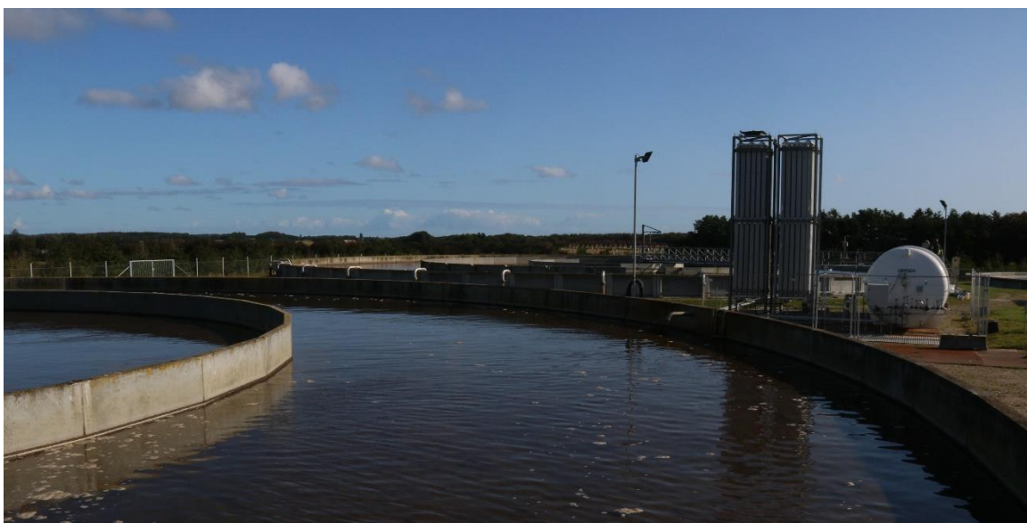
Procestank på Mariagerfjord Renseanlæg © Mariagerfjord Vand A/S.
