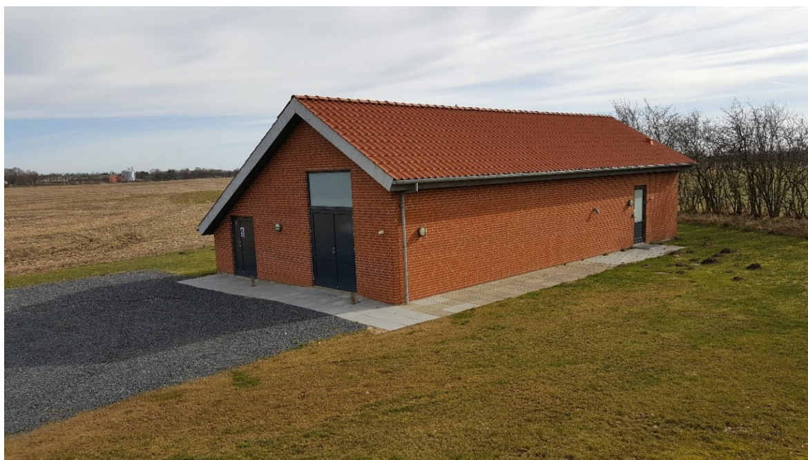
Foto: Skjellerup Vandværk
